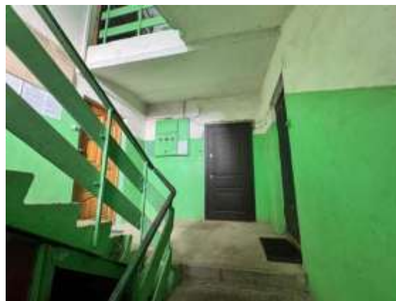
1.stāva kāpņu telpa
